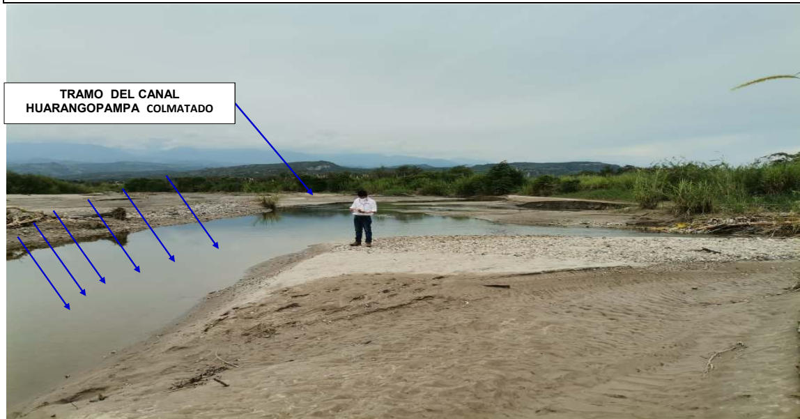
FIGURA N°01: TRAMO DEL CANAL A NIVEL DEL CAUCE LO QUE EN EPOCA DE AVENIDA ES AFECTADO EN SU TOTALIDAD
